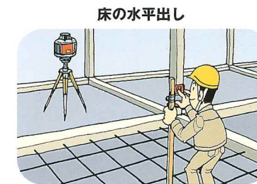
床の水平出し 土台・床面のコンクリート打ちに、バカ棒に受光器を取り付けて一人でスムーズに水平出し。
